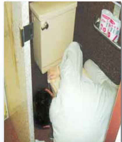
洋便器修理状況
