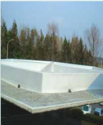
ポーチ屋上塗装
